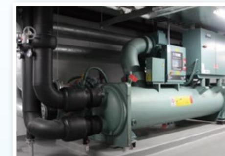
通过离心式变频水冷冷冻机的投入使用，较之前节电80%。
